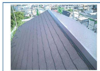
金属板やコロニアル葺きに改修
